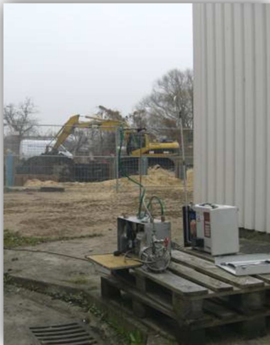
baubegleitende Messungen in der Umgebungsluft
