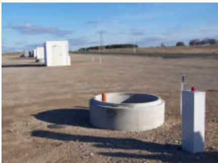
Mediencontainer mit Schmutzwasserhebeanlage
