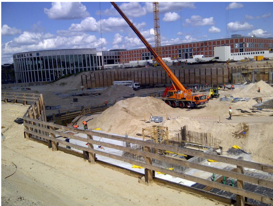
Baugrube mit Blick zum Messe- eingang Süd
