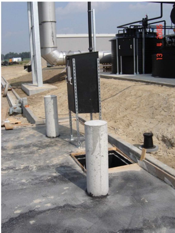
Bau der WHG-Fläche mit Säurebefüllstation
