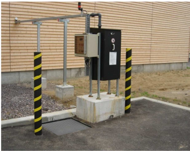
Säurebefüllstation
