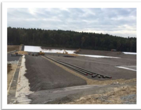
Herstellung Basisabdichtung DK II Bereich
